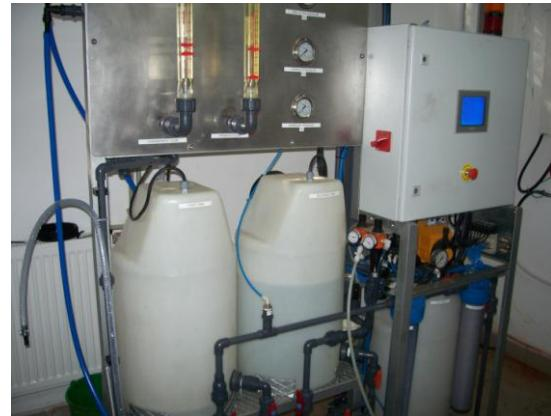
**Fig. 11 Instalatii de ultrafiltrare/nanofiltrare**
